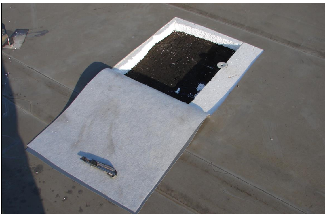
Foto 2: SONDA 1; pod svrchní vervou z PVC fólie tl. 1 mm je netkaná textilie tl. 0,5 mm a pěnový polystyren tl. 50 mm, pod kterým je souvrství asfaltových lepenek pojených asfaltovými nátěry celkové tl. cca 17 mm
