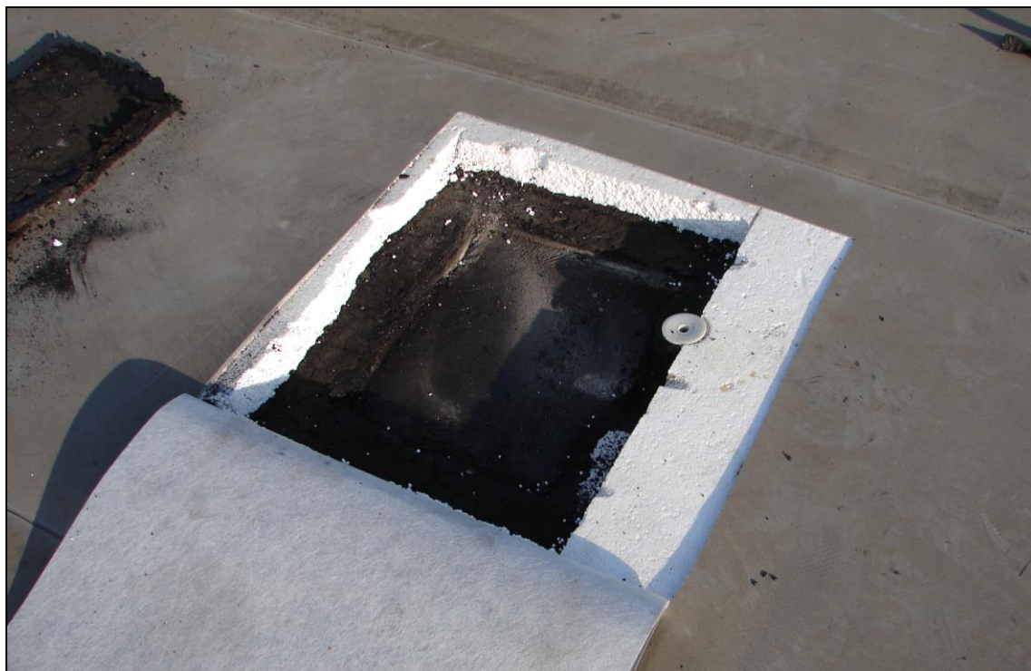
Foto 3: SONDA 1; pod souvrstvím asfaltových lepenek pojených asfaltovými nátěry celkové tl. cca 17 mm je betonový potěr tl. 25 mm
