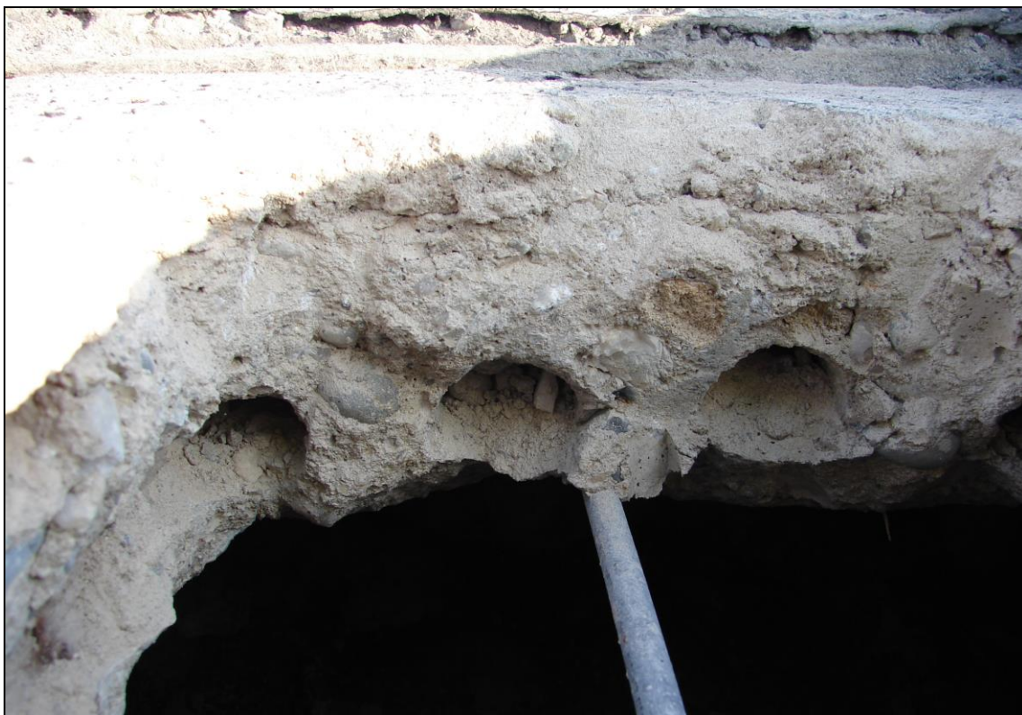
Foto 5: SONDA 1; detail dutinové PZD desky tl. 90 mm, dutiny Ø cca 30 mm, spodní výztuž desky Ø 8 mm, kruhový průřez s hladkým povrchem
