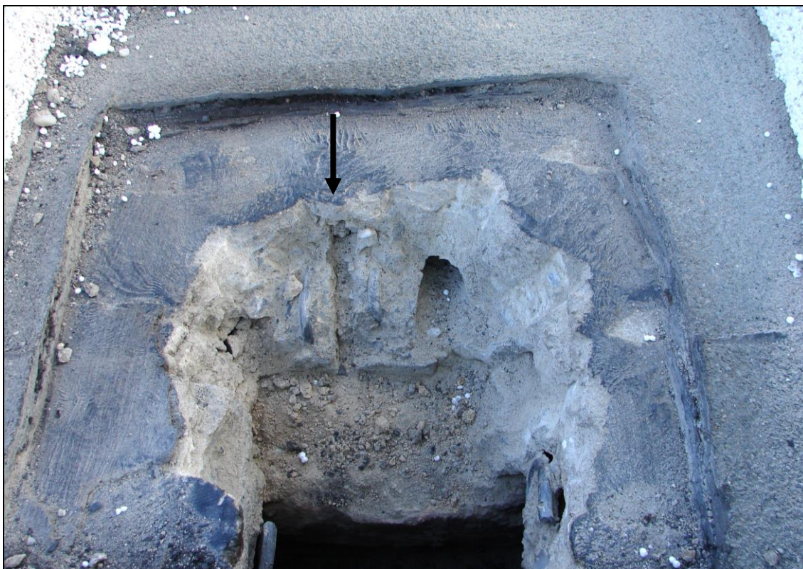
Foto 24: SONDA 2; dutina Ø cca 30 mm v PZD desce, šipkou vyznačena spára mezi PZD deskami v příčné směru budovy - foto 31
