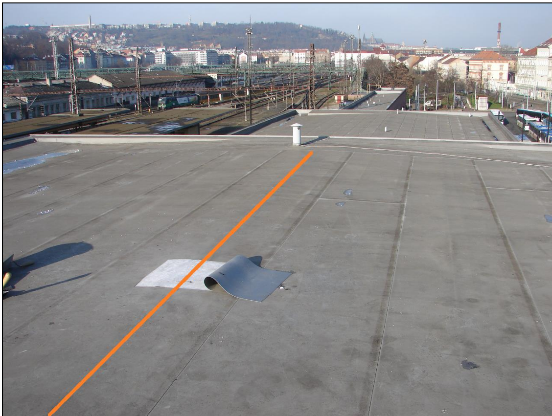
Foto 31: SONDA 2; čarou je vyznačen směr zděných pasů, na které jsou uloženy PZD desky
