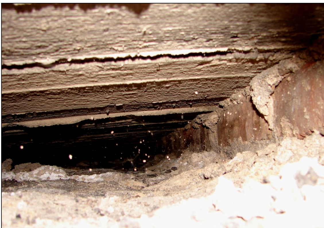
Foto 25 a 26: SONTA 1; PZD desky jsou uloženy na zděných pasech (CP), které jsou v podélném směru budovy (foto 31), světlá vzdálenost zděných pasů cca 1,8 m, ve spádu jsou PZD desky, jejich spád je zajištěn stupňovanou výškou zděných pasů
