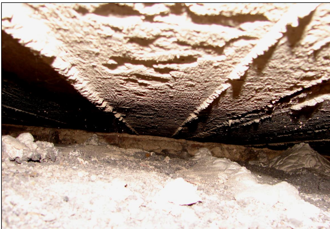
Foto 27 a 28: SONTA 2; v pozadí zděný pas (CP) v podélném směru budovy (foto 31), na který jsou uloženy PZD desky
