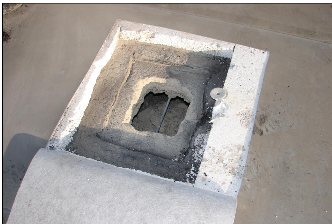
Foto 4: SONDA 1; pod betonovým potěrem tl. 25 mm jsou dutinové PZD desky tl. 90 mm (šířka desky 300 mm, délka cca 1950 mm), na foto je otvor proražený skrze PZD desku, patrná je i spodní výztuž desky Ø 8 mm kruhového průřezu s hladkým povrchem
