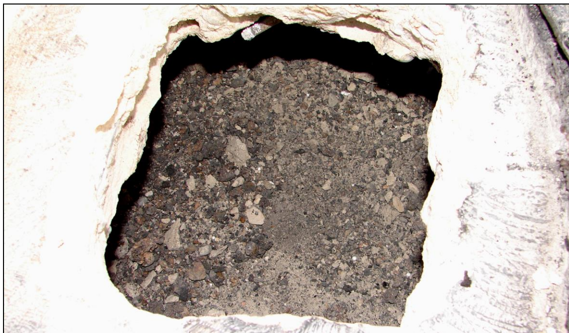
Foto 7: SONDA 1; detail škvárového násypu tl. 90 - 100 mm, na povrchu násypu jsou drobné úlomky betonu z PZD desky
