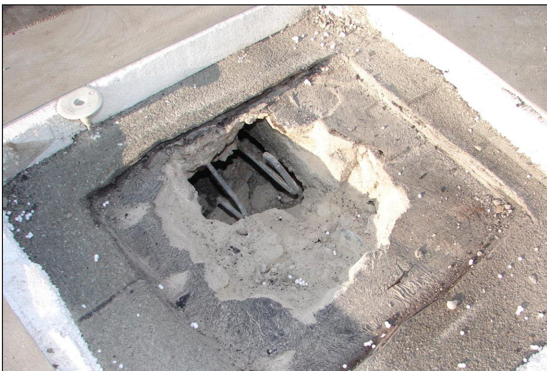
Foto 20: SONDA 2; pod betonovým potěrem tl. 20 mm jsou dutinové PZD desky tl. 90 mm (šířka desky 300 mm, délka cca 1950 mm), na foto je otvor proražený skrze PZD desku, patrná je výztuž desky kruhového průřezu s hladkým povrchem, horní: Ø 8 mm (zakončena hákem nahoru), spodní: Ø 6 mm (zakončena hákem dolů)
