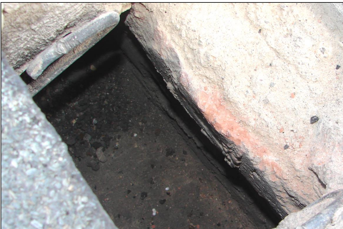
Foto 29 a 30: SONDA 2; po odstranění škvárového násypu je patrný horní líc ŽB stropní konstrukce, na foto je též patrný zděný pas
