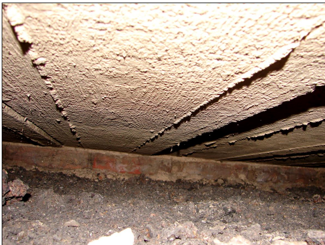
Foto 8: SONDA 1; PZD desky jsou uloženy na zděných pasech (CP), které jsou v podélném směru budovy (foto 12), světlá vzdálenost zděných pasů cca 1,8 m, ve spádu jsou PZD desky, jejich spád je zajištěn stupňovanou výškou zděných pasů
