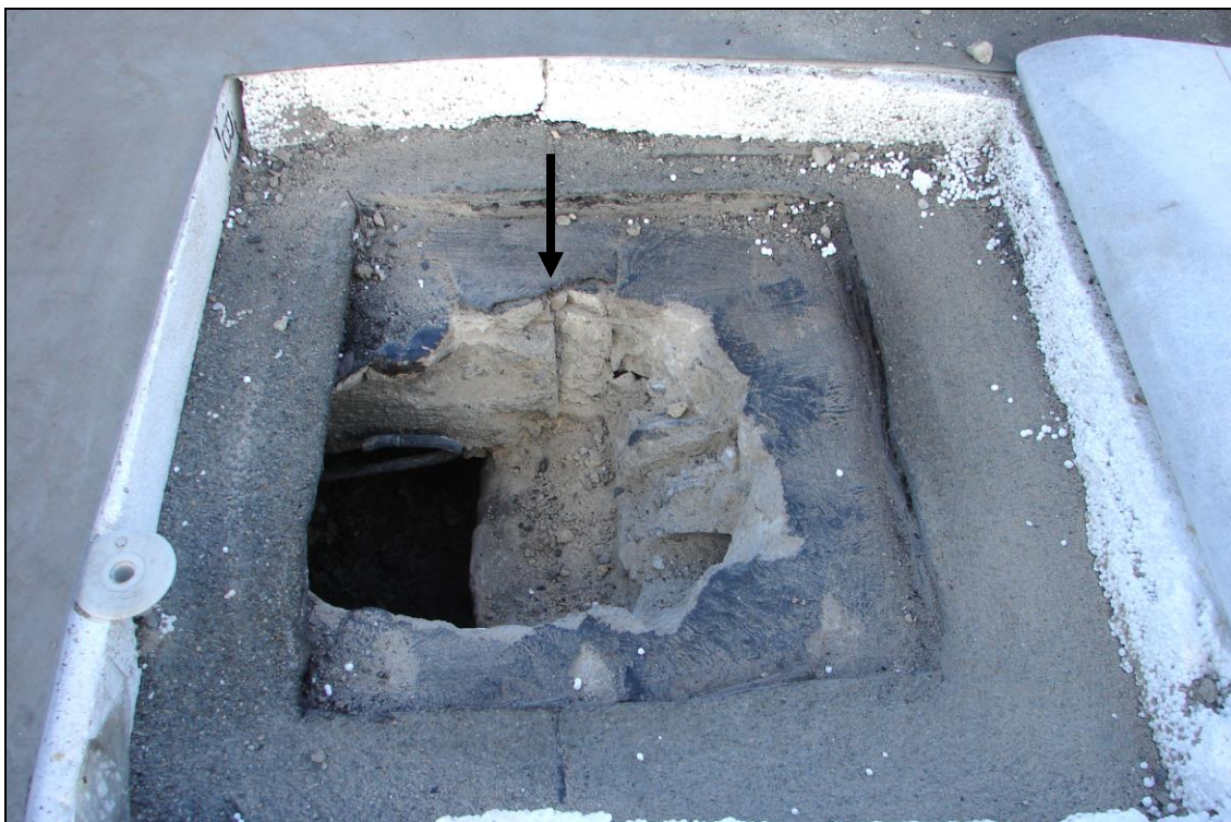
Foto 23: SONDA 2; šipkou vyznačena spára mezi PZD deskami v podélném směru budovy (spára nad zděným pasem) - foto 31
