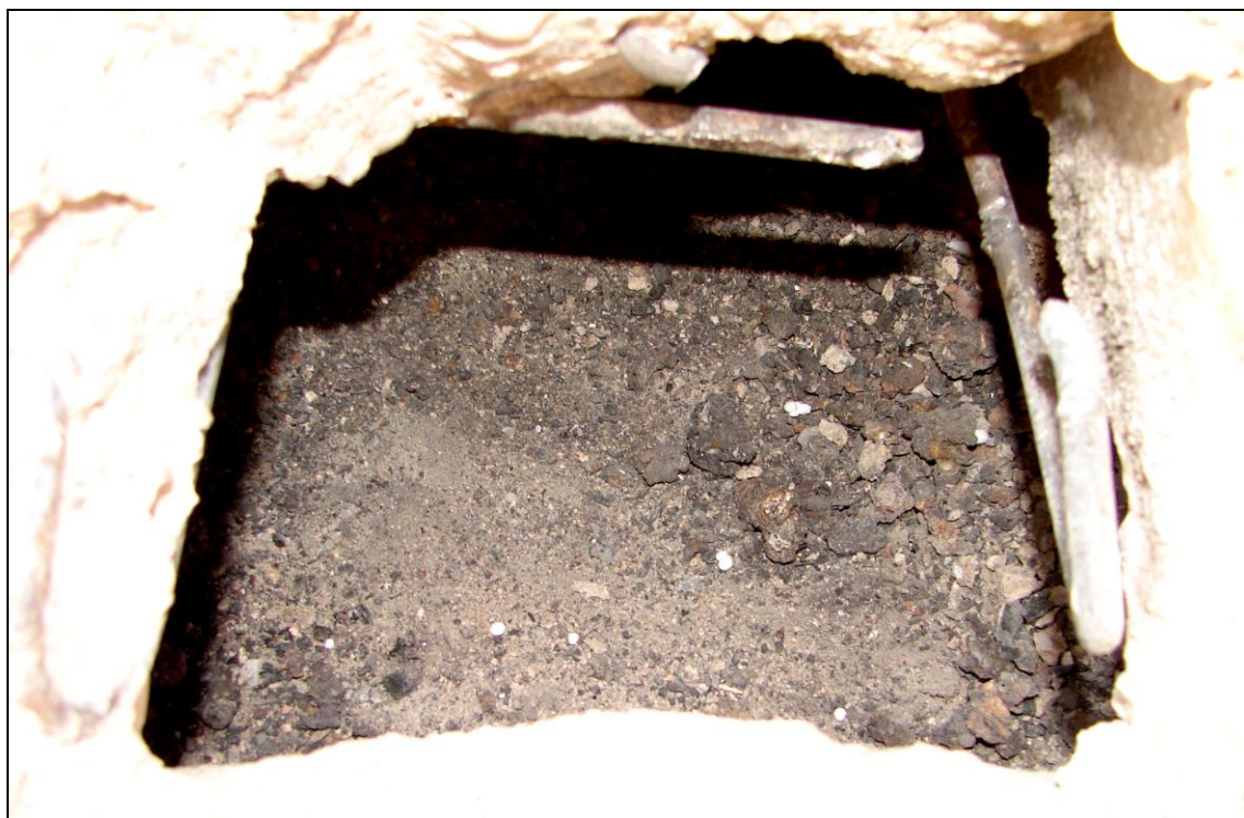
Foto 21 a 22: SONTA 2; pod PZD deskami je vzduchová mezera, otvorem v PZD desce je patrný škvárový násyp tl. 90 - 100 mm (na foto je již odstraněna horní výztuž PZD desky), patrná je horní výztuž desky Ø 8 mm a příčná výztuž Ø 8 mm (obě výztuže kruhového průřezu s hladkým povrchem)
