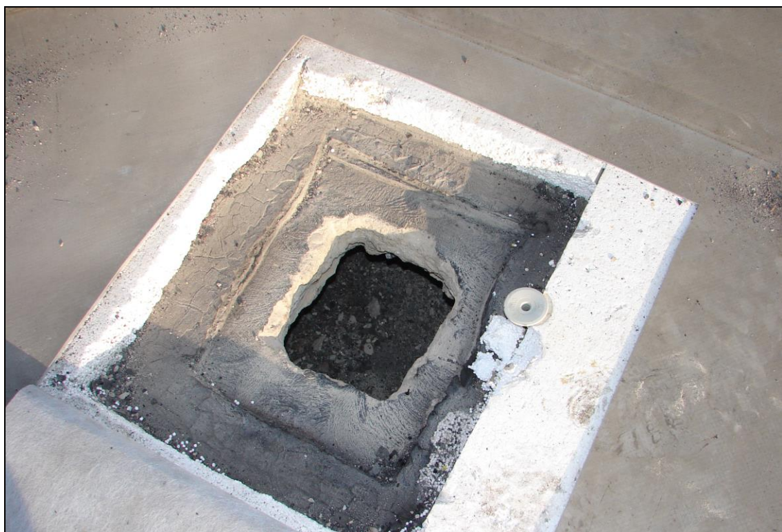
Foto 6: SONDA 1; pod PZD deskami je vzduchová mezera, otvorem v PZD desce je patrný škvárový násyp tl. 90 - 100 mm (na foto je již odstraněna výztuž PZD desky)
