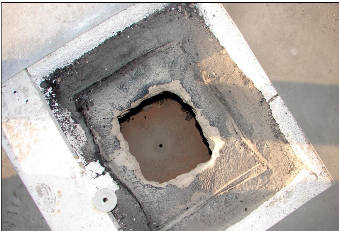
Foto 13 a 14: SONTA 1; dle zadání byla v sondě 1 zjišťována tloušťka nosné stropní konstrukce (desky ŽB trémového stropu), v sondě byl skrze desku proveden vrt Ø 10 mm, zjištěná tloušťka stropní desky = 138 mm (odhadovaná chyba měření ± 1 mm)
