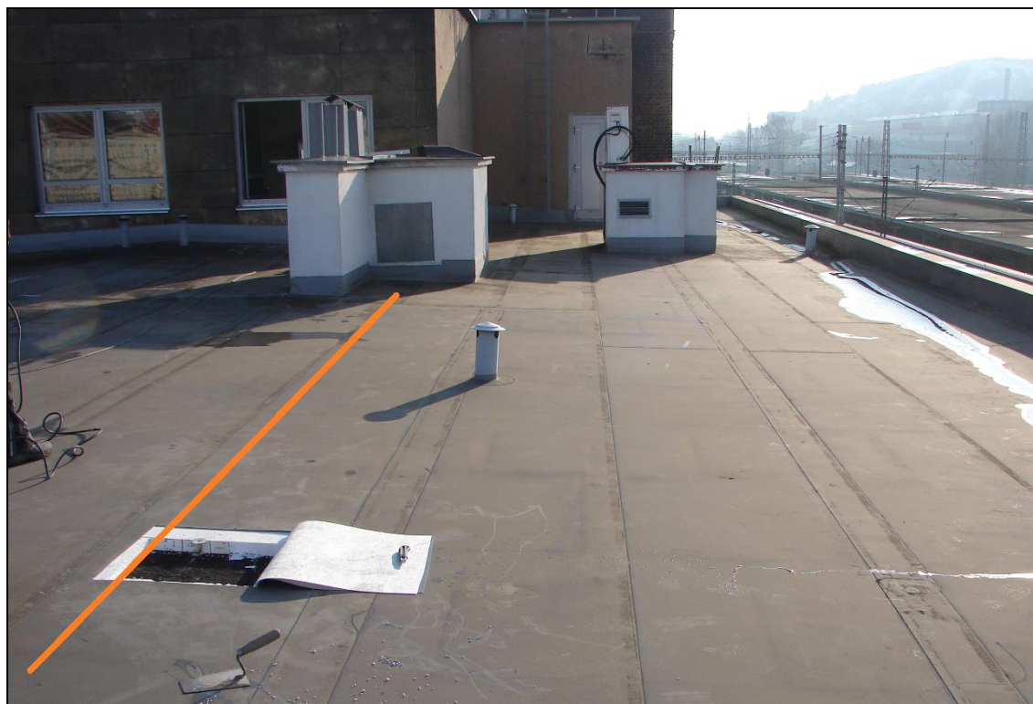
Foto 12: SONDA 1; čarou je vyznačen směr zděných pasů, na které jsou uloženy PZD desky
