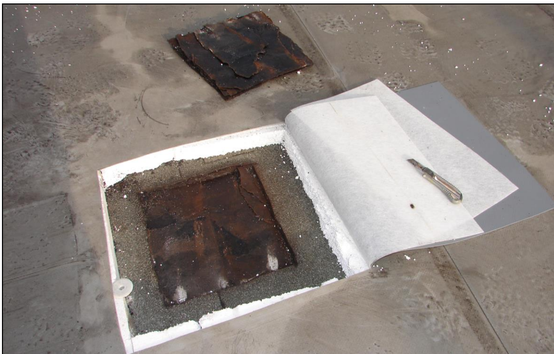
Foto 19: SONDA 2; pod souvrstvím asfaltových lepenek pojených asfaltovými náterý celkové tl. cca 13 mm je betonový potěr tl. 20 mm
