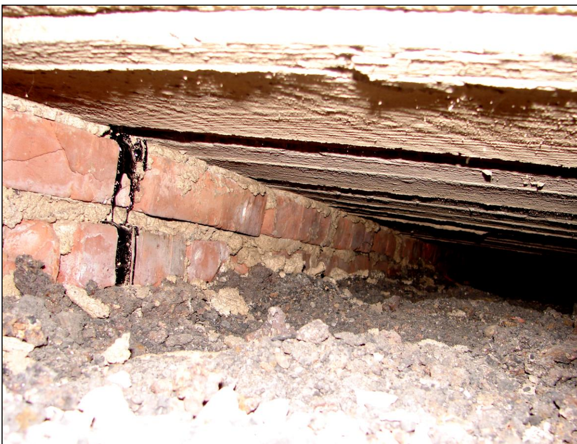
Foto 9 a 10: SONTA 1; zděný pas (CP) v podélném směru budovy (foto 12), na který jsou uloženy PZD desky
