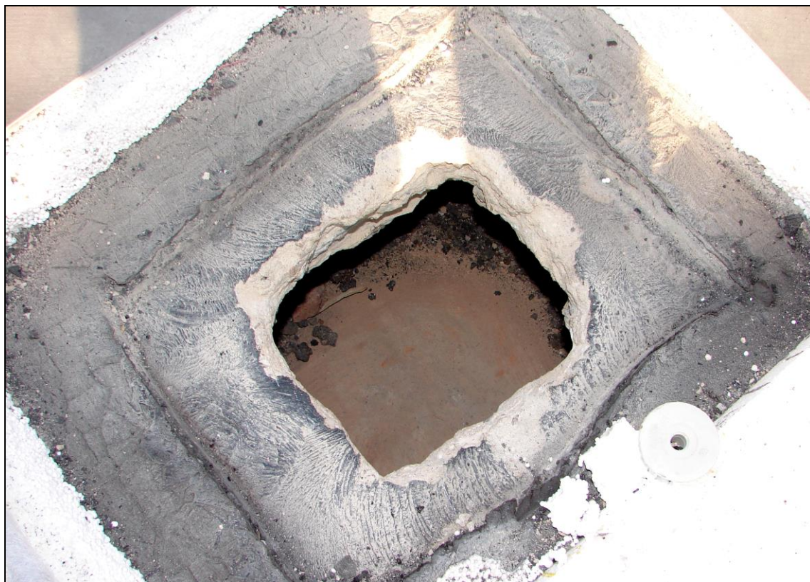
Foto 11: SONDA 1; po odstranění škvárového násypu je patrný horní líc ŽB stropní konstrukce
